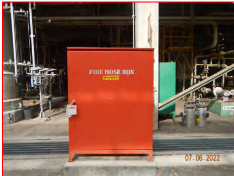
ภาพที่ 2.2-40 หัวจ่ายน้ำดับเพลิง/ ตู้เก็บอุปกรณ์ดับเพลิง
