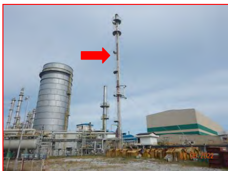
ภาพที่ 2.2-4 หอเผาทั้งระดับเหนือพื้นดิน (Elevated Flare)
