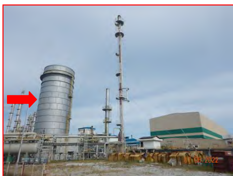
ภาพที่ 2.2-5 หอเผาทั้งระดับพื้นดินแบบมิดชิด (Enclosed Ground Flare)
