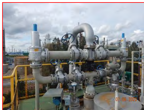
ภาพที่ 2.2-65 วาล์วระบายความดัน (Pressure Relief Valve) ที่ตั้งกักเก็บ
