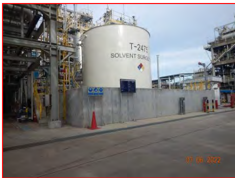
ภาพที่ 2.2-58 กำแพงกั้นบริเวณถังเก็บสำรองสารเคมี
