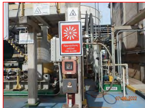
ภาพที่ 2.2-49 Fire Alarm Manual System
