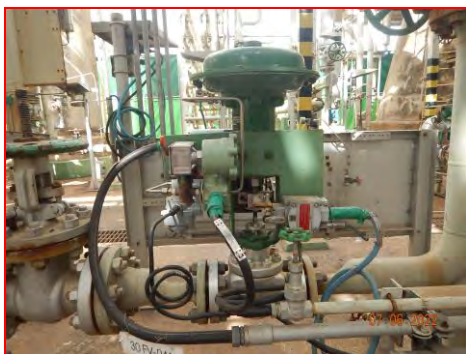
ภาพที่ 2.2-34 Control Valve เป็นชนิด Low Noise
