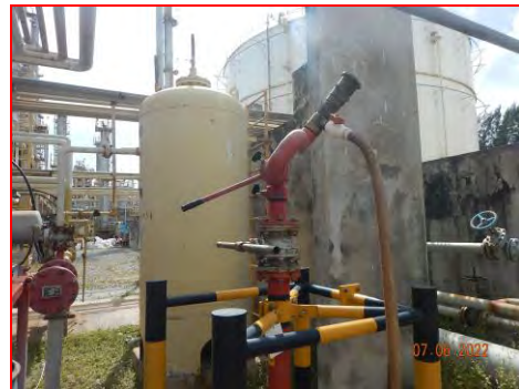
ภาพที่ 2.2-43 ระบบ Foam ดับเพลิง
