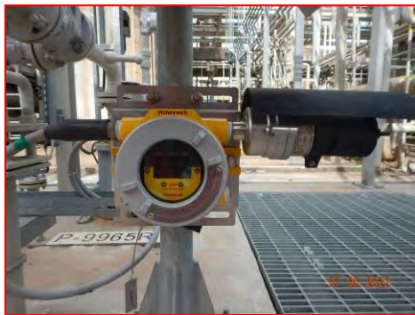
ภาพที่ 2.2-46 Gas Detector ในพื้นที่กระบวนการผลิต
