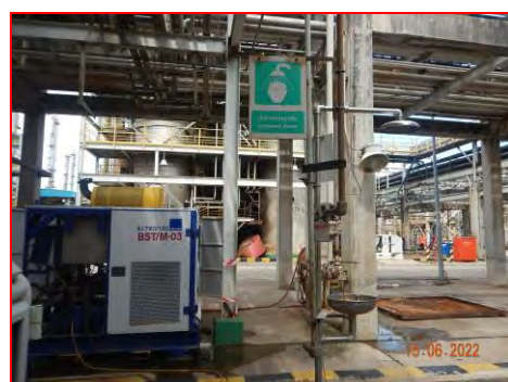
ภาพที่ 2.2-53 อ่างล้างตา ฝักบัวล้างตา และที่ชำระล้างฉุกเฉิน
