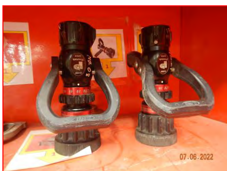
ภาพที่ 2.2-52 Firewater Nozzle
